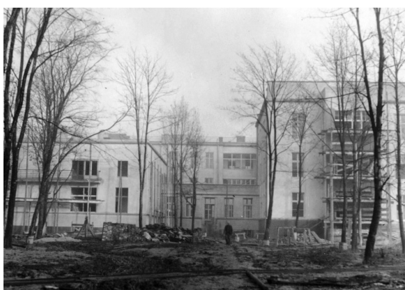
Rycina 6. Budynek kliniczny Instytutu Radowego podczas prac wykończeniowych, widok od strony przyszłego ogrodu (ze zbiorów Narodowego Archiwum Cyfrowego)
