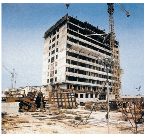
Rycina 30. Budowa nowej siedziby Instytutu Onkologii na Ursynowie – powstaje budynek naukowy (ze zbiorów Redakcji Naukowej NIO-PIB)
