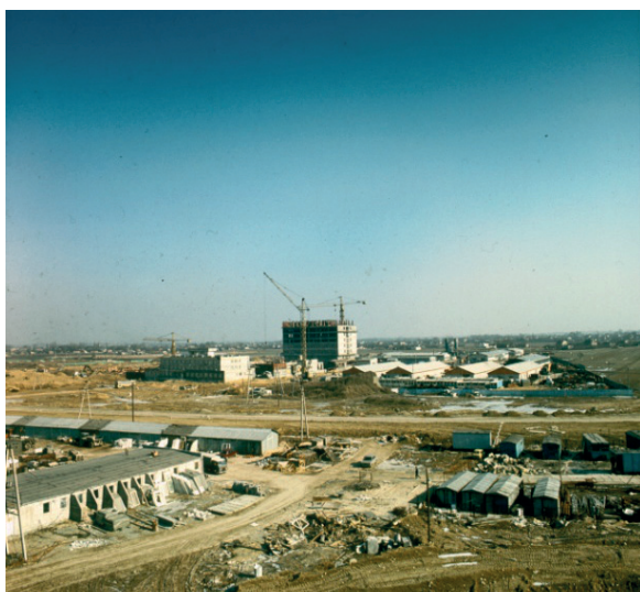
Rycina 29. Budowa nowej siedziby Instytutu Onkologii na Ursynowie, koniec lat 70. (ze zbiorów Redakcji Naukowej NIO-PIB)
